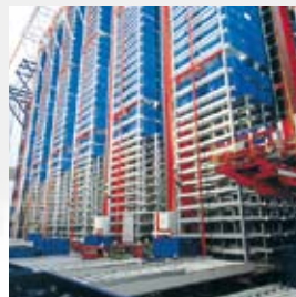
Almacenaje con estanterías industriales informatizadas para la logística más eficaz
